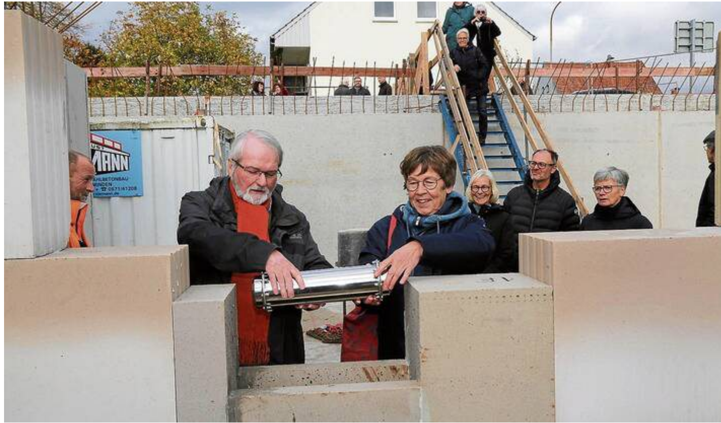
Eberhard Koch und Perdita Berg versenken die Zeitkapsel im Mauerwerk des Kellergeschosses von „Zeitlos“-Wohnen.
