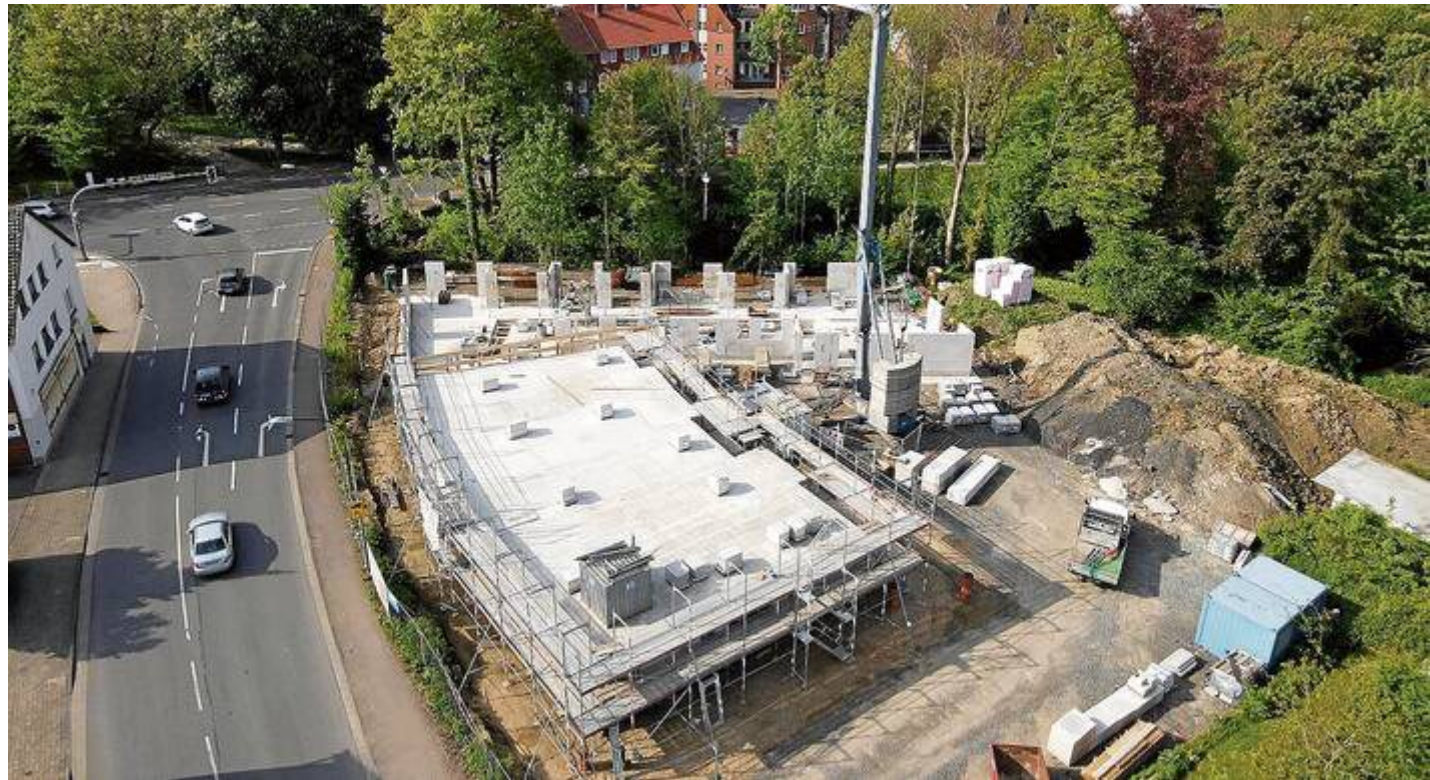
Der Rohbau für das „Zeitlos“-Wohnprojekt befindet sich in vollem Gange.
